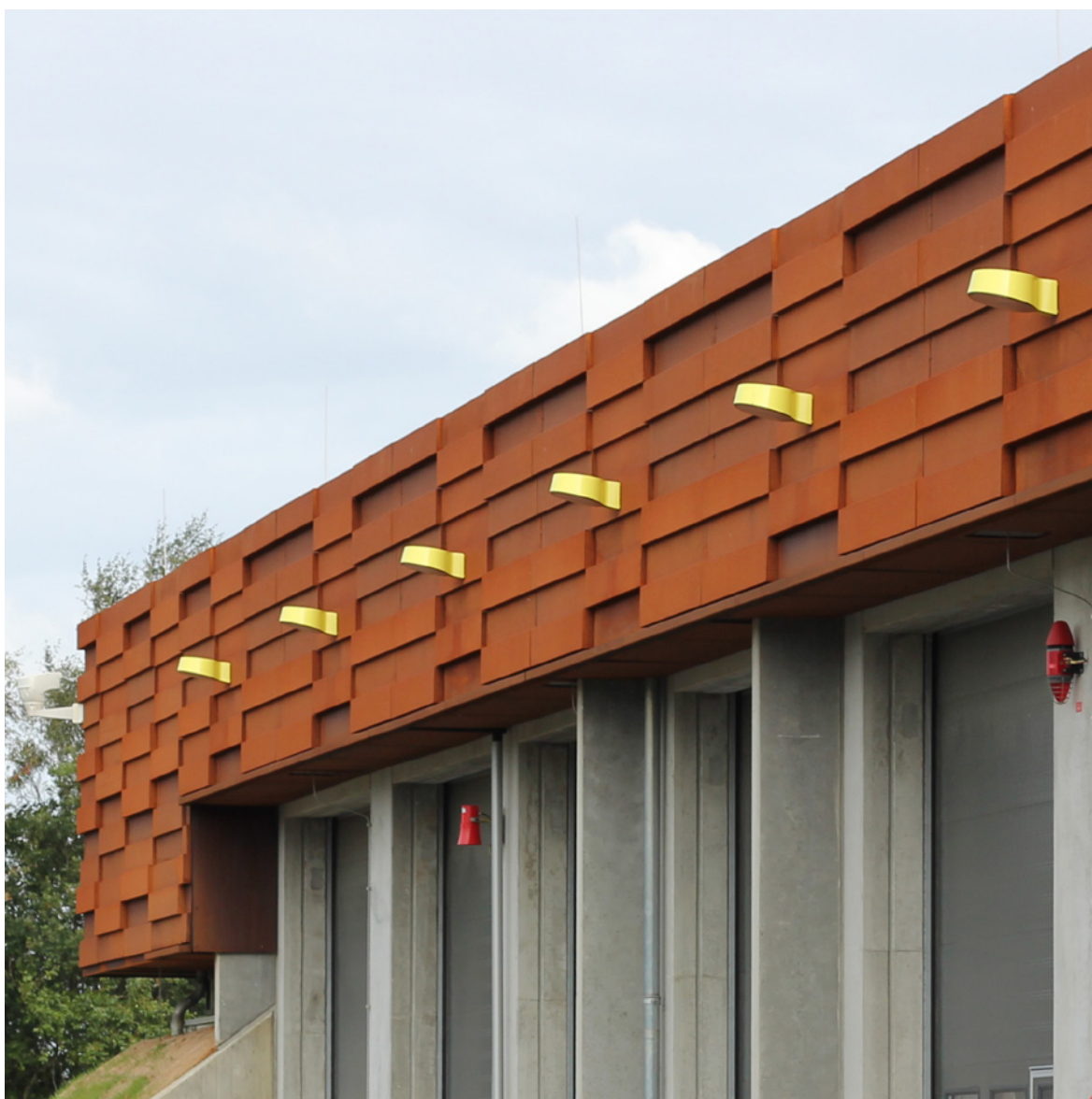
Egtved Gaskompressorstation, arkitekt: C.F. Møller
